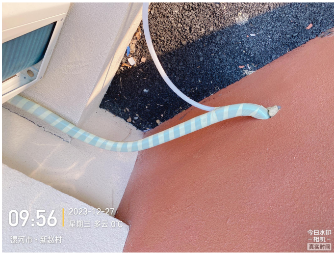
现场检验照片
