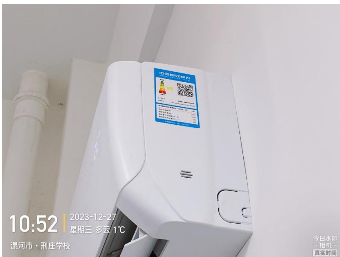
现场检验照片
