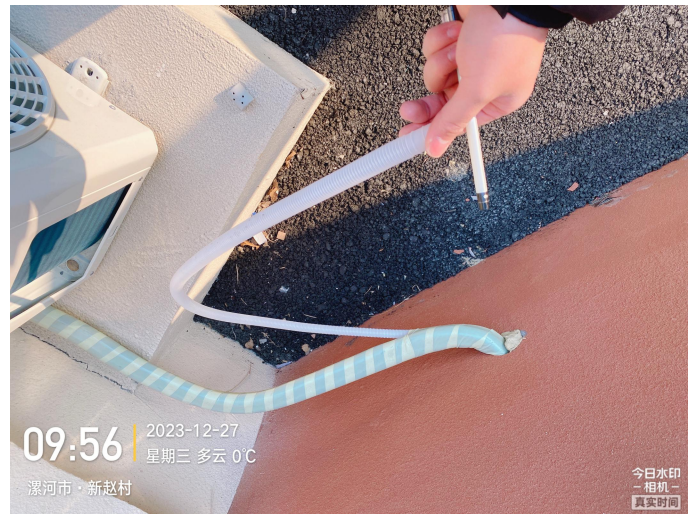
现场检验照片
