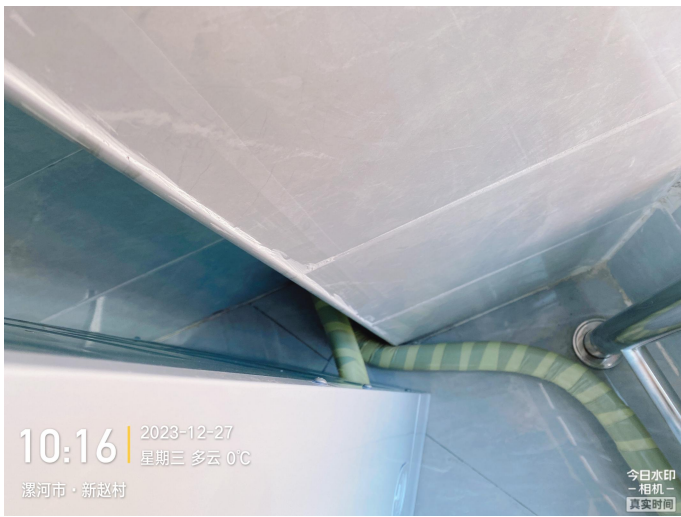
现场检验照片
