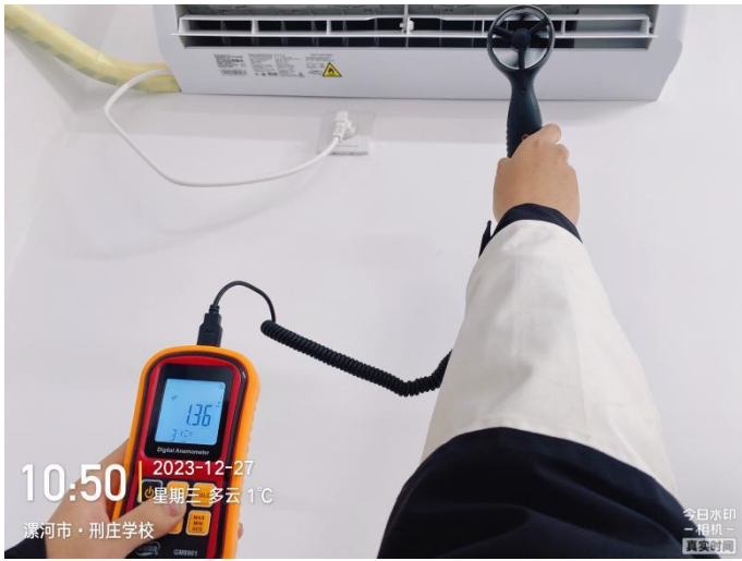
现场检验照片
