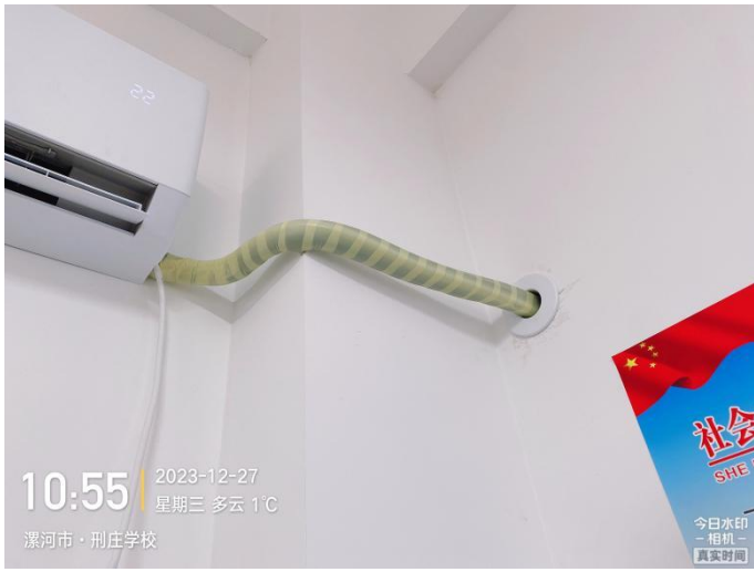
现场检验照片
