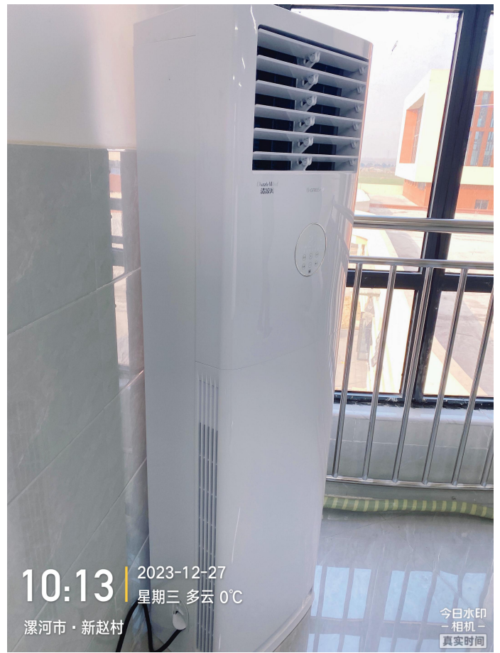
现场检验照片
