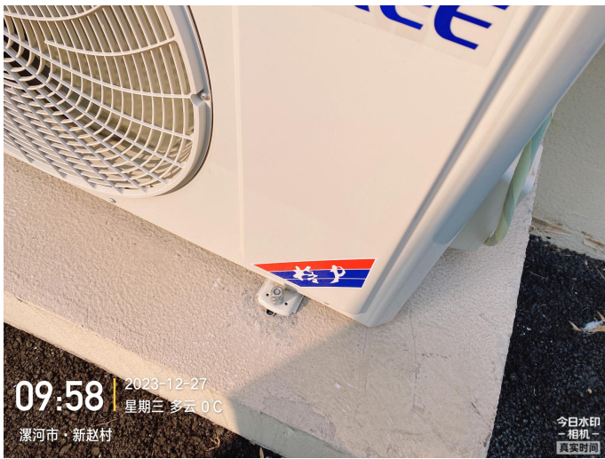
现场检验照片
