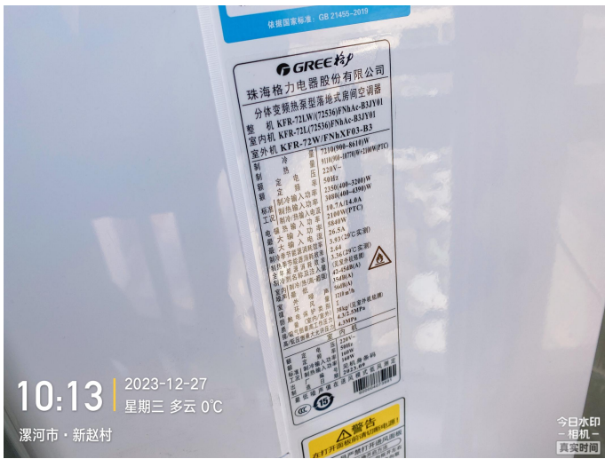
现场检验照片
