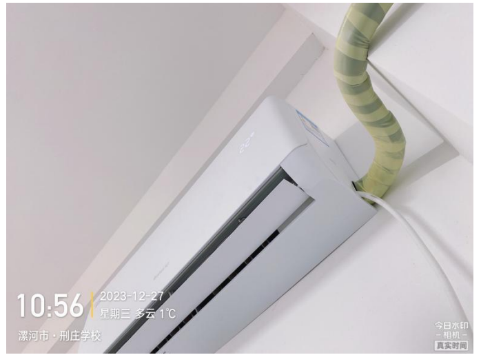
现场检验照片
