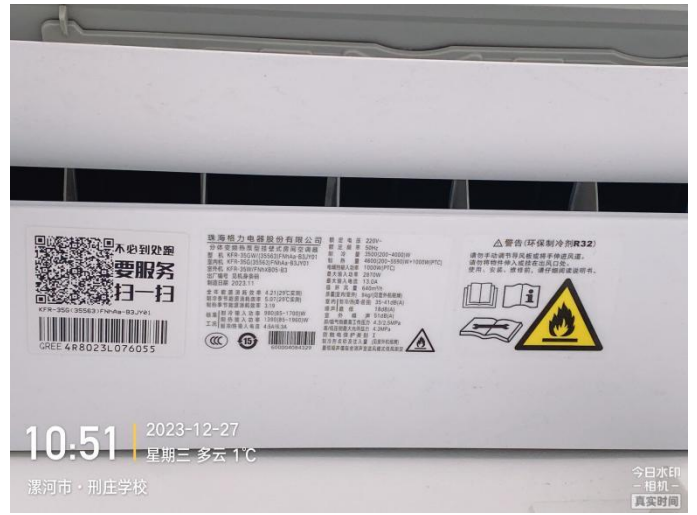
现场检验照片
