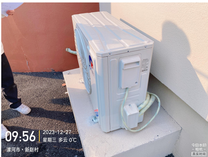
现场检验照片
