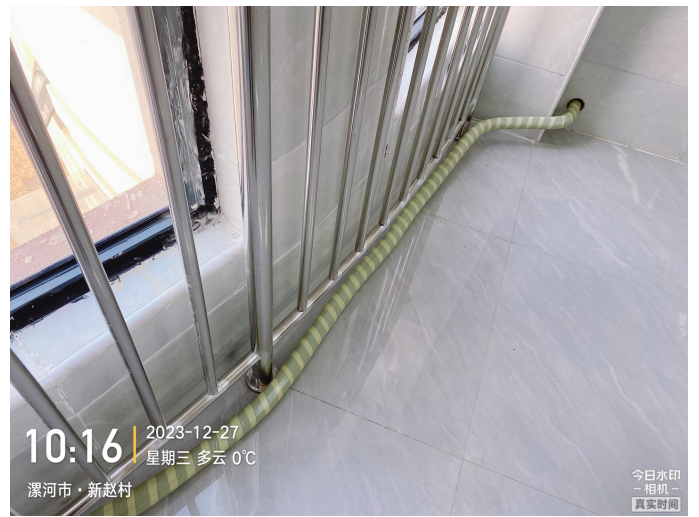
现场检验照片
