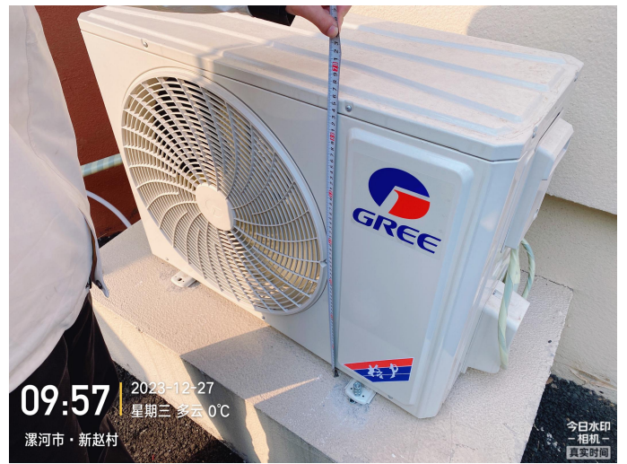
现场检验照片
