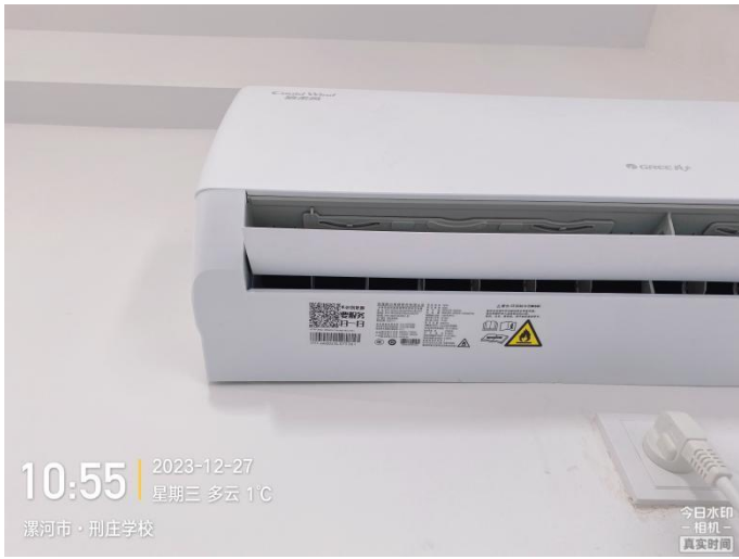
现场检验照片
