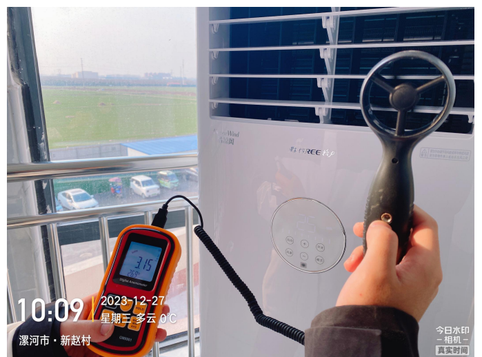
现场检验照片
