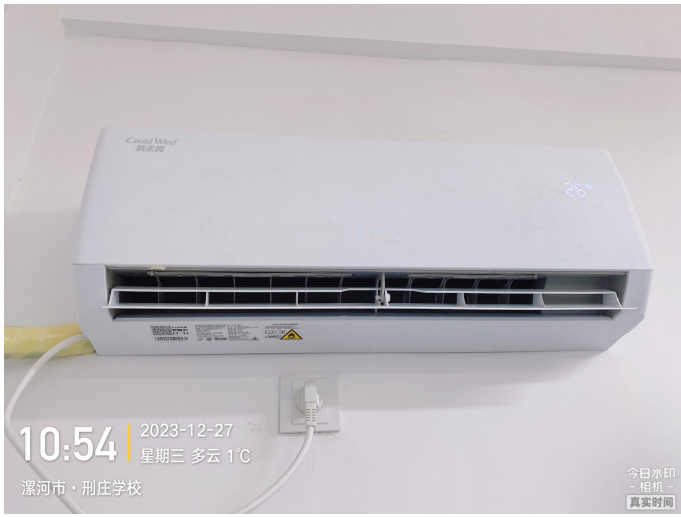
现场检验照片
