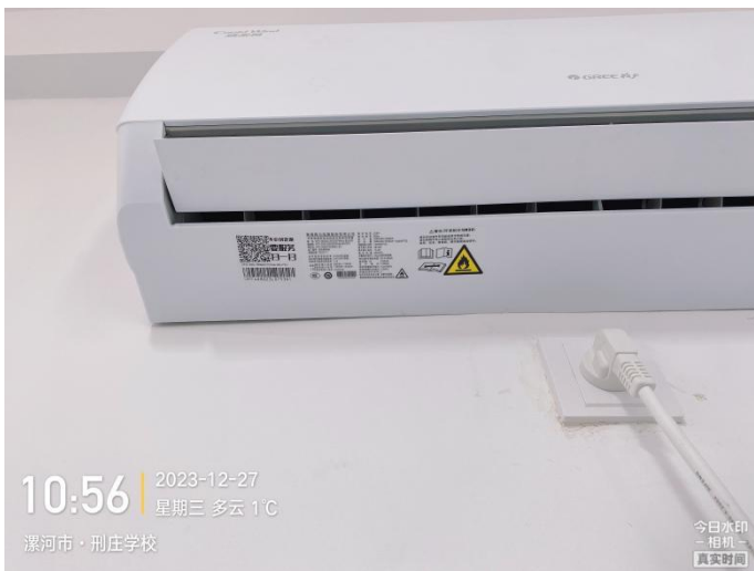
现场检验照片
