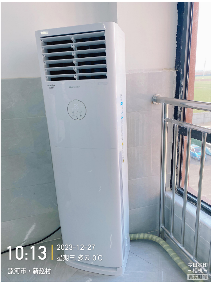
现场检验照片
