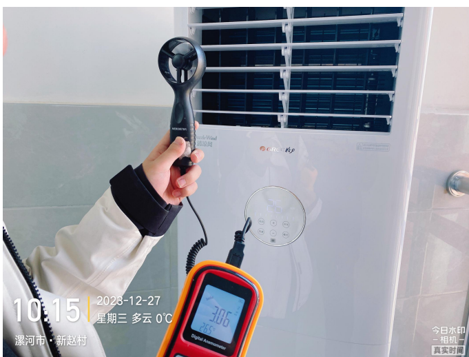
现场检验照片
