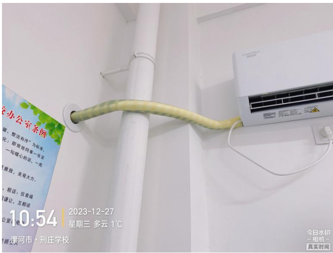
现场检验照片
