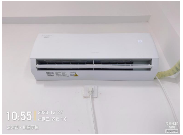
现场检验照片
