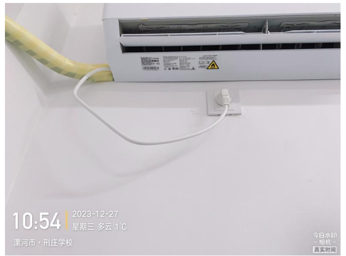
现场检验照片
